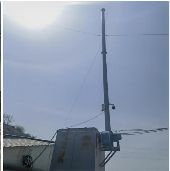
图 3-2 袋式除尘器+20 排气筒
