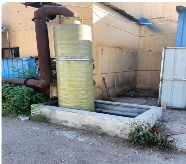
图 3-5 喷淋式脱硫除尘器
