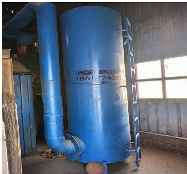
图3-1 脱硝装置
